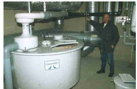
Aquatron 4x300 mit 8 angeschlossenen WC
