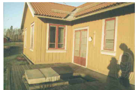
Einstieg zum Außenkeller unter der Terasse
