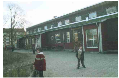
Augustenborgsskolan in Malmö: Erweiterungsbau in ökologischer Bauweise
