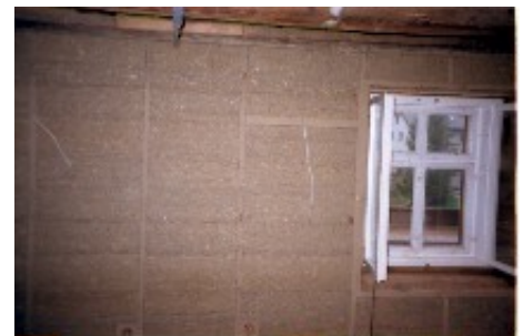
Wand mit Hanf-Lehm-Mischung, noch unverputzt
