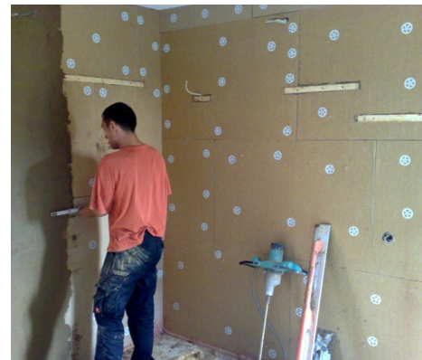
Holzweichfaser-Dämmplatten und Lehmputz
