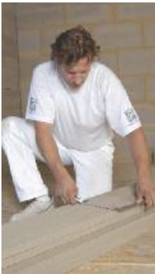
Mit dem Winkel den Schnitt anlegen
