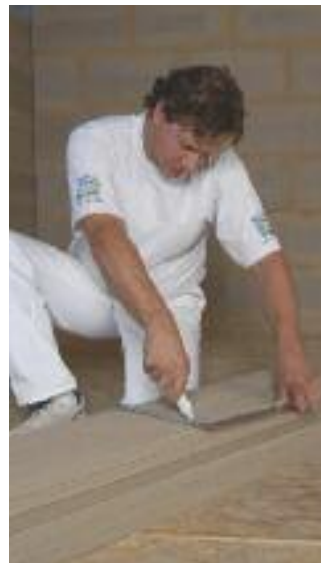
Mit dem Cuttermesser 2 bis 3 mal ritzen
