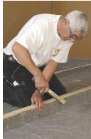
Einbau der Rieselschutzbahn
