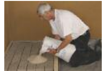
Einbau des gebrannten Quarzsandes
