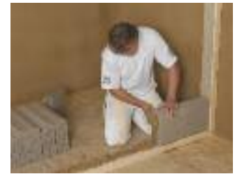
Anstreichen der Stoßfuge
