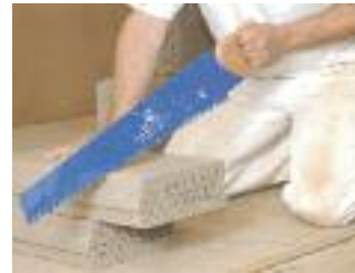
Zuschnitt mit der Porotonsäge
