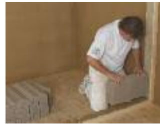
Aufsetzen des Lehmelements
