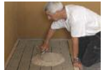
Die Fugen vollständig mit Quarzsand füllen
