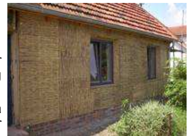
Wärmedämmung von außen
