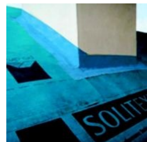
Anschluss der SOLITEX am Schornstein mit BUDAX TOP
