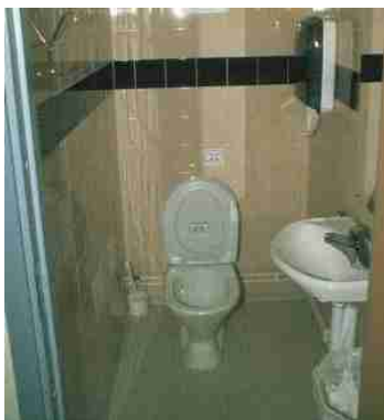
Normales WC mit 3 Liter-Spülung mit Anschluss an ein Aquatron
