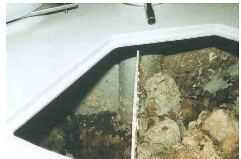
Aquatron 4x300 in Benutzung; links: 1. Kammer nach 2 Jahren Kompostierung, rechts: 4. Kammer mit frischem Material
