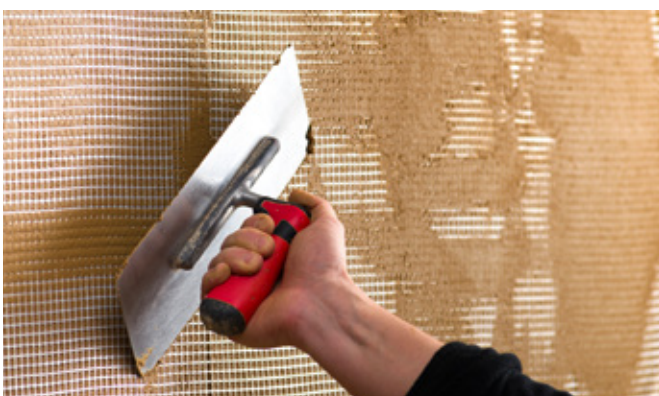
7. Gewebe einbetten und überdecken
