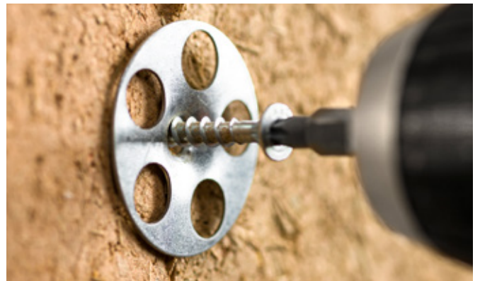
4. Befestigen, z. B. mit Haltetellern
