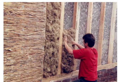
Einbringen der Hanf-Dämmwolle
