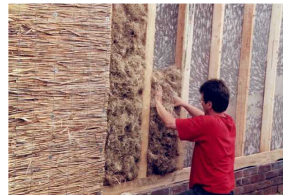
Einbringen der Hanf-Dämmwolle
