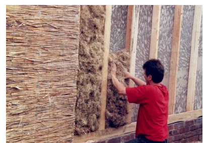
Einbringen der Hanf-Dämmwolle
