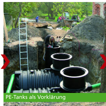
Aushub für Bodenfilter
