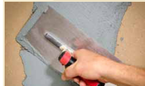
Edelputz mit der Edelstahl-Glättekelle auftragen
